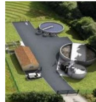
La station d'épuration sera fonctionnelle en 2020.
